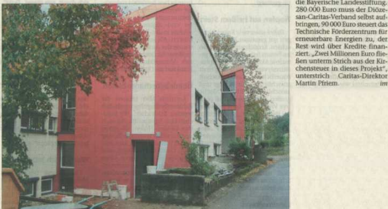
Nicht mehr wiederzuerkennen sind die Häuser im Kinder- und Jugenddorf nach der Sanierung. Das erste Haus ist fertig, die beiden Wohngruppen können nächste Woche einziehen.
